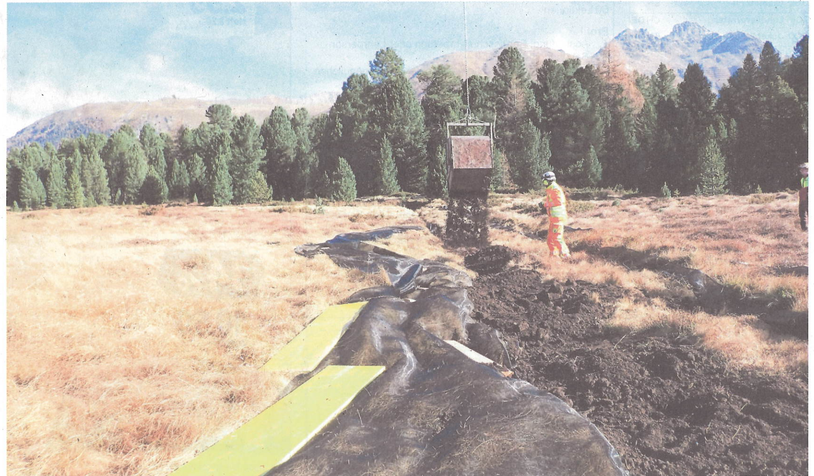
Der Graben wird mit Torf gefüllt. Um nicht in das fragile Gelände fahren zu müssen, wird der Torf mit dem Helikopter transportiert.
