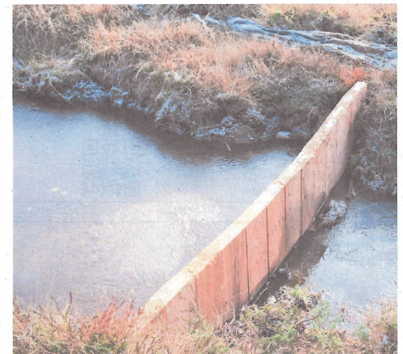
Die Auswirkungen der eingebauten Spundwand lassen sich bereits jetzt erkennen.
